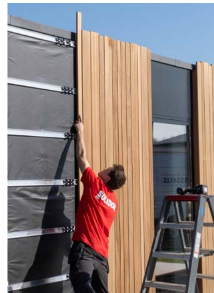
© Solidor - Linup: zonder zichtbare schroeven of ingewikkelde montage
