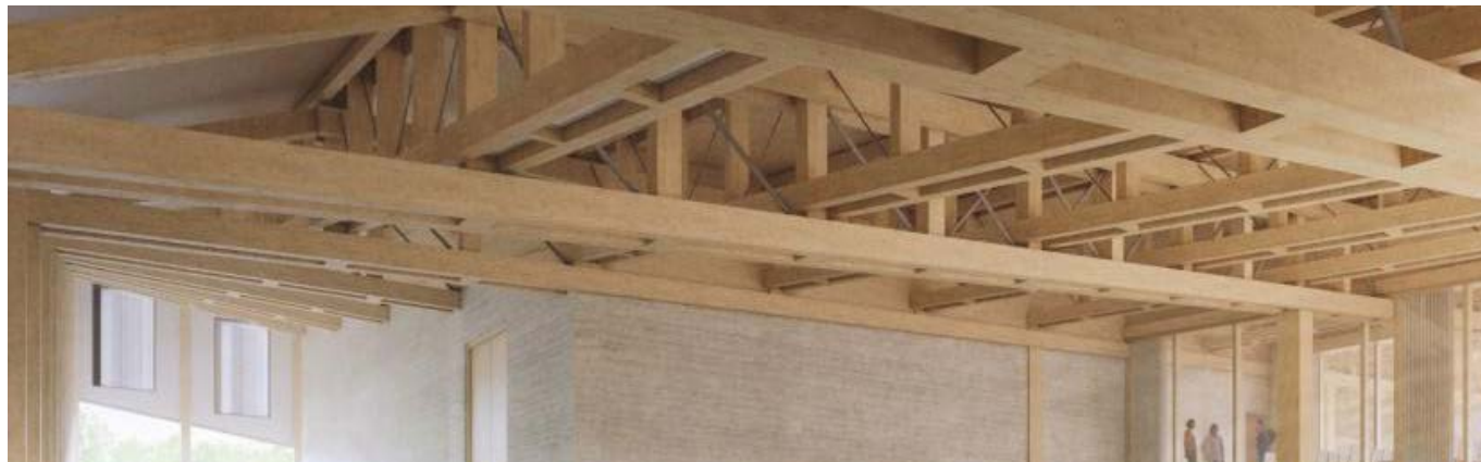
© studiomarcvermeulen - De draagstructuur is opgebouwd uit houten kolommen, houten spanten en kruislaagshouten dakplaten
