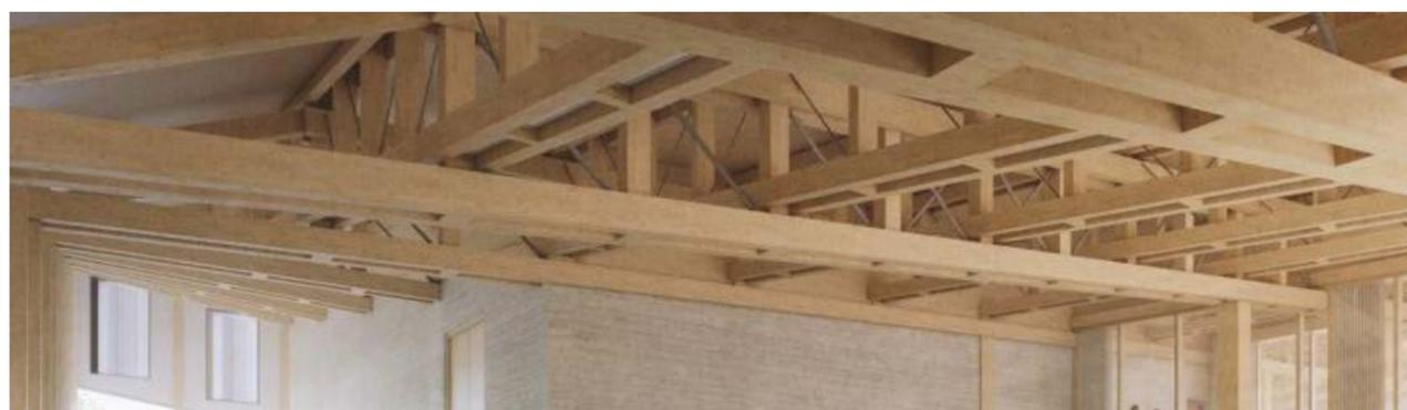
© studiomarcvermeulen - La structure porteuse se compose de colonnes en bois, de fermes en bois ainsi que de panneaux de toiture en bois lamellé-croisé.
