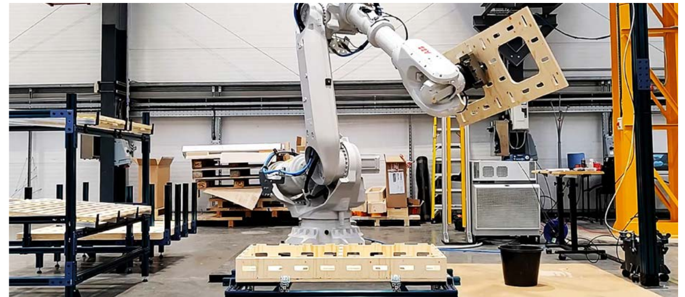
Vandenbussche bouwt in Aalter een gespecialiseerde ‘microfabriek’ om modulaire woonunits te bouwen die door robots werden geproduceerd.
