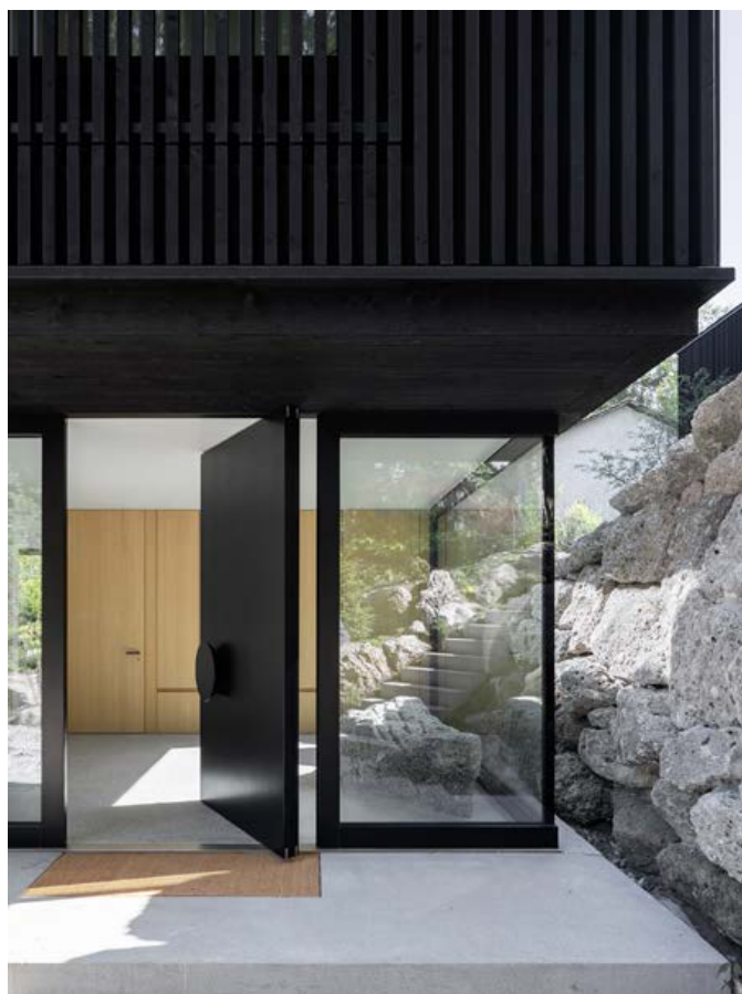
De inkom met niet-dragende glasgevel. De oversteek van de kubus erboven wordt gedragen door de met staal versterkte houtconstructie
