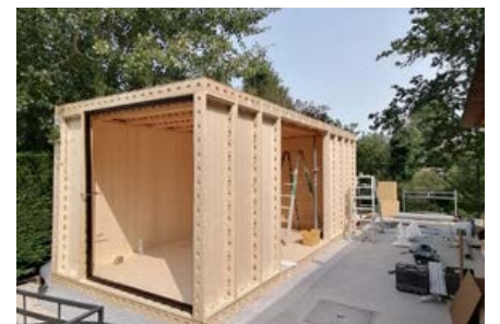
Een eerste testopstelling: de houten units waaruit dit tuinhuis is opgebouwd, werden door robots gemaakt.
