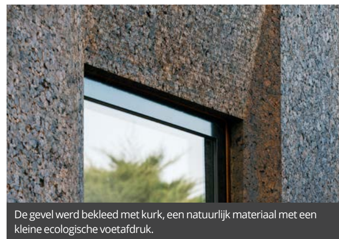
De combinatie CLT en kurk zorgt voor ademde gevels en een gezond binnenklimaat.
