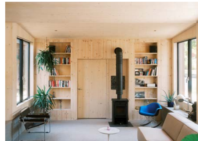
Le bois devait rester visible. La structure CLT sert donc aussi de finition intérieure.
