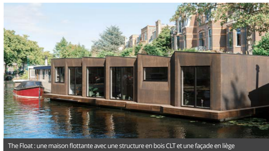
La façade est revêtue de liège, un matériau naturel à faible empreinte écologique.
