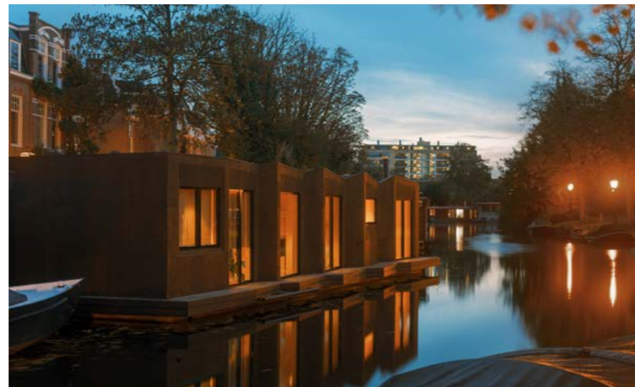
La façade est revêtue de liège, un matériau naturel à faible empreinte écologique.
