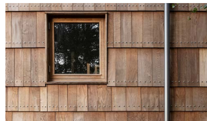
© Johan Dehlin – Meer dan 20.000 roestvrijstalen schroeven houden de gevelbekleding op zijn plaats
