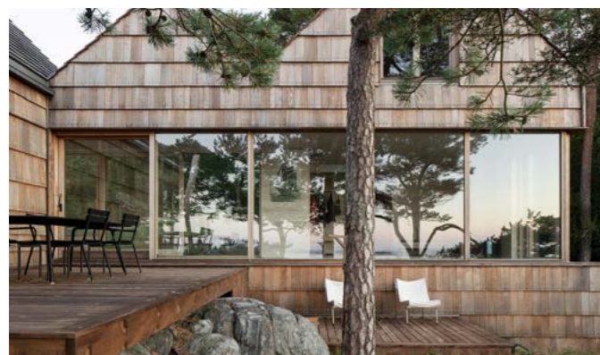
© Johan Dehlin – De offcuts komen van een fabrikant van houten vloerplanken
