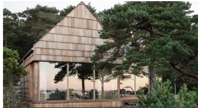
© Johan Dehlin – Cachée parmi les arbres, cette maison de vacances idyllique a été dotée d'une couverture de toit et d'un bardage de façade réalisés à partir de chutes de bois.
