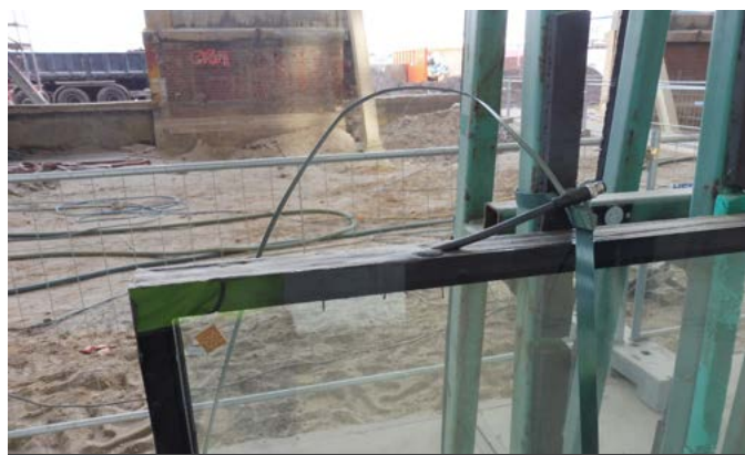
© Groven+ – Dynamisch glas installeren betekent ook heel wat kabels en connectoren wegwerken
