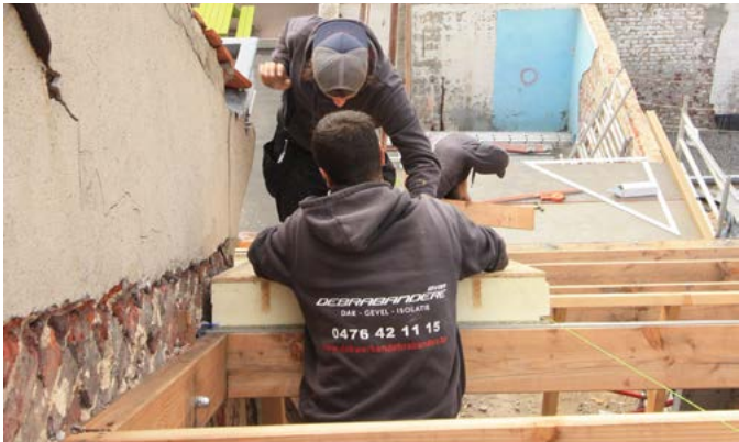
© De Poort vzw – Het dak werd met veel aandacht voor isolatie en luchtdichtheid vernieuwd
