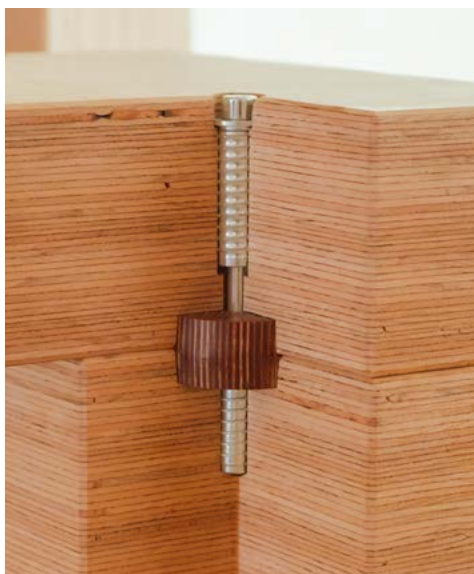
© t-lab Holzarchitektur und Holzwerkstoffe - Detail schroefverbinding
