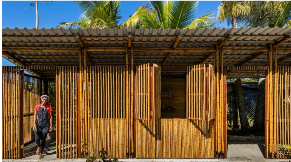
Het project waarmee het allemaal startte : de bouw van een gemeenschapscentrum in Brazilië
