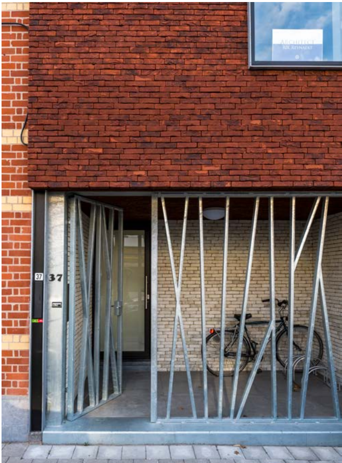
© De Poort vzw – De gelijkvloerse gevel werd een 2-tal meter achteruit geplaatst om hem toch voldoende te kunnen isoleren
