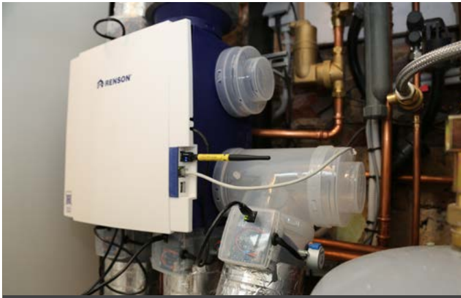
Vraaggestuurde afvoer van vervuilde lucht met de Healthbox 3.0 ventilatie-unit
