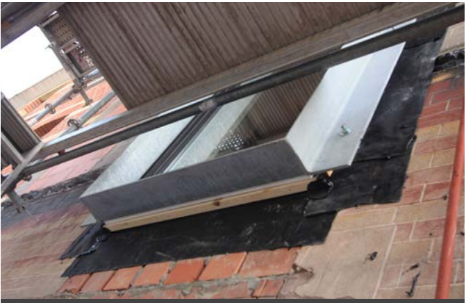
© De Poort vzw – Zorgvuldig aangebrachte EPDM houdt water en wind buiten
