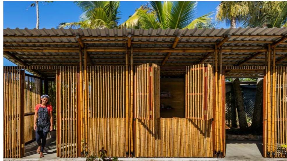
Le projet par lequel tout a commencé : la construction d'un centre communautaire au Brésil
