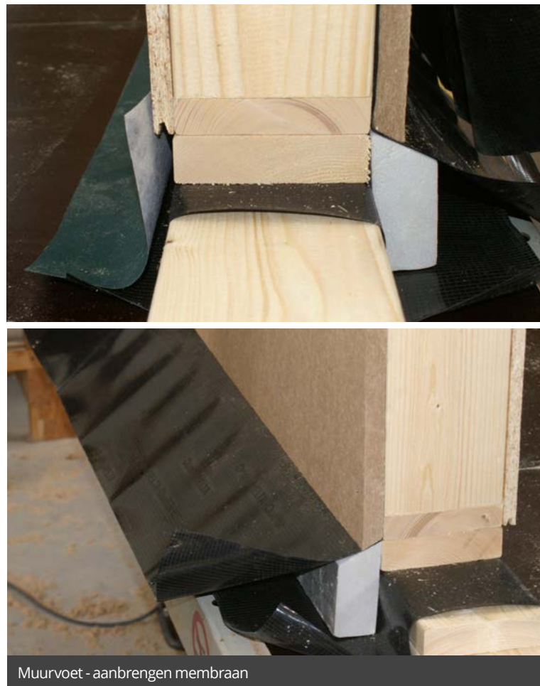
Muurvoet - aanbrengen membraan
