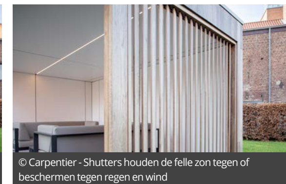
© Carpentier - De voorgevel en zijgevel zijn uitgevoerd in thermisch essen
