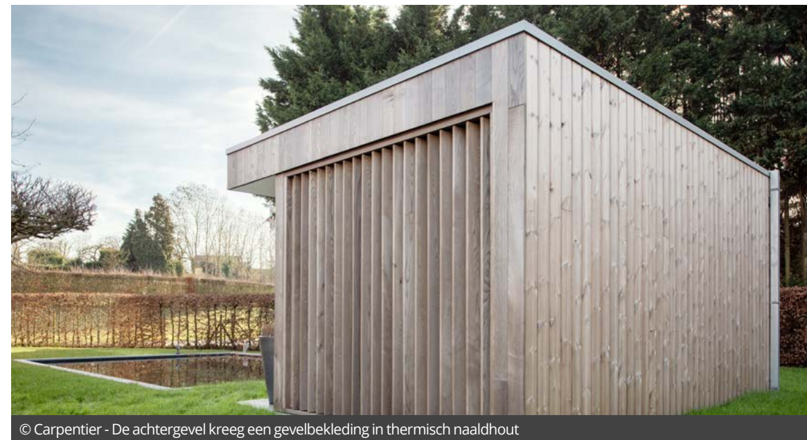
© Carpentier - De achtergevel kreeg een gevelbekleding in thermisch naaldhout
