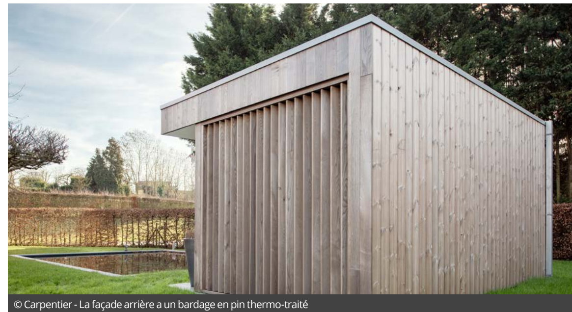
© Carpentier - La façade arrière a un bardage en pin thermo-traité
